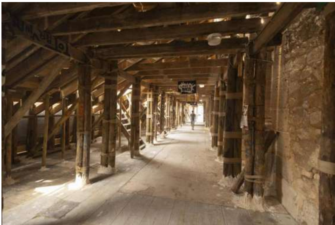
Estructura de madera que ha obtenido la declaración de BIC. / PERALES IBORRA
